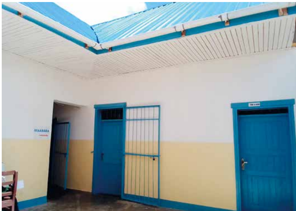
Nieuw dak voor de medische post in Mtwango.
